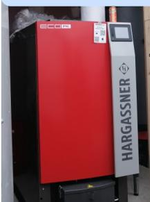
La chaudière à fioul, qui datait de 2003 et qui engendrait une consommation excessive, a été remplacée par une chaudière à granulés.
